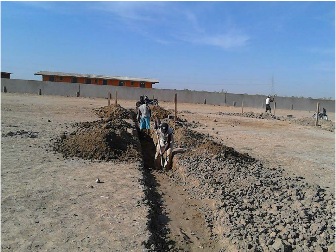
Foto 1 – Inizio scavo delle fondamenta dell’Ospedale.
