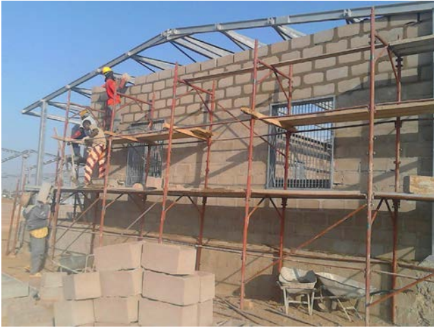
Foto 4 -5 – Edificazione de muri perimetrali dell’Ospedale.
