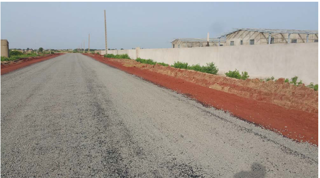
Foto 8 –Strada di accesso all’intero Villaggio “Don Mario Pasini” realizzata dalle autorità governative.
