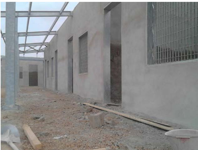
Foto 6 – 7 - Realizzazione intonaci interni ed esterni
